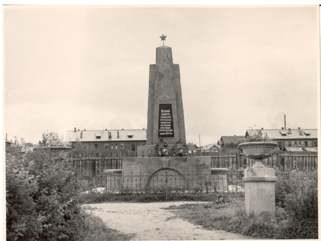
Вид с севера на южную часть, 1960-е годы.
